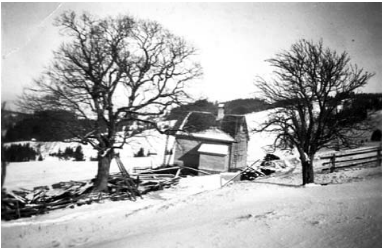
Renovation im Frühjahr 1926, mit dem Gebälk des zerstörten Gadens.
